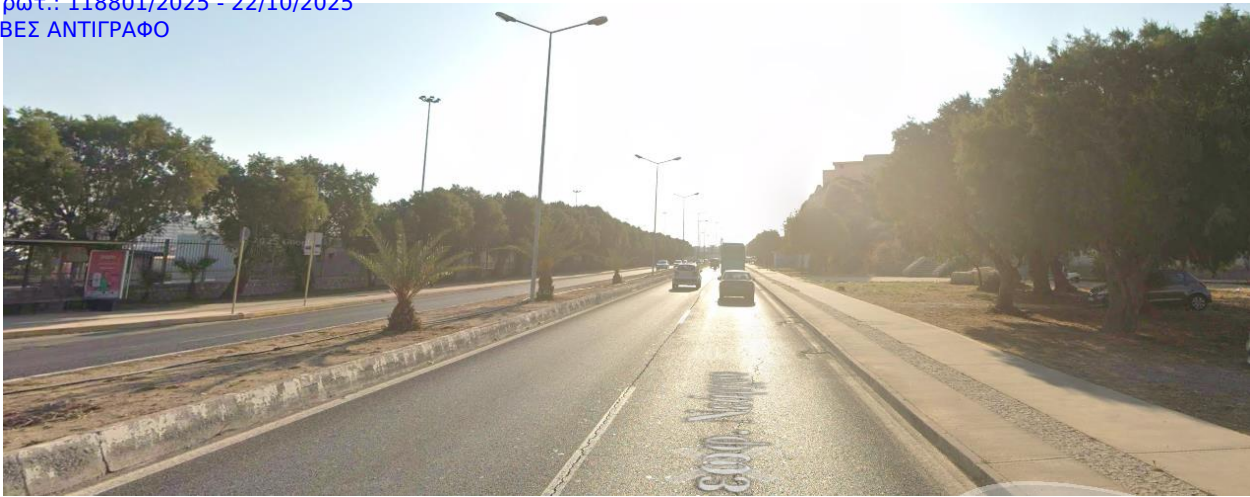
Εικόνα 3 υφιστάμενη κατάσταση επί της Λ. Νεάρχου (νότια).
