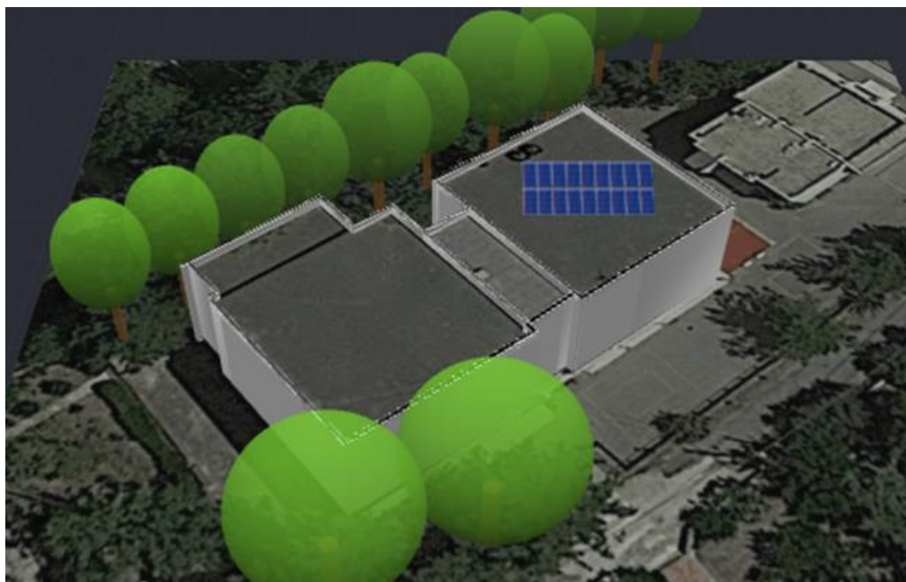
Εικόνα 3: Ενδεικτική χωροθέτηση Φ/Β πλαισίων στο ανατολικό (δεξί) τμήμα του δώματος του κτιρίου Σχολείου του κτιριακού συγκροτήματος Γυμνασίου/Λυκείου Αγίου Μύρωνα
