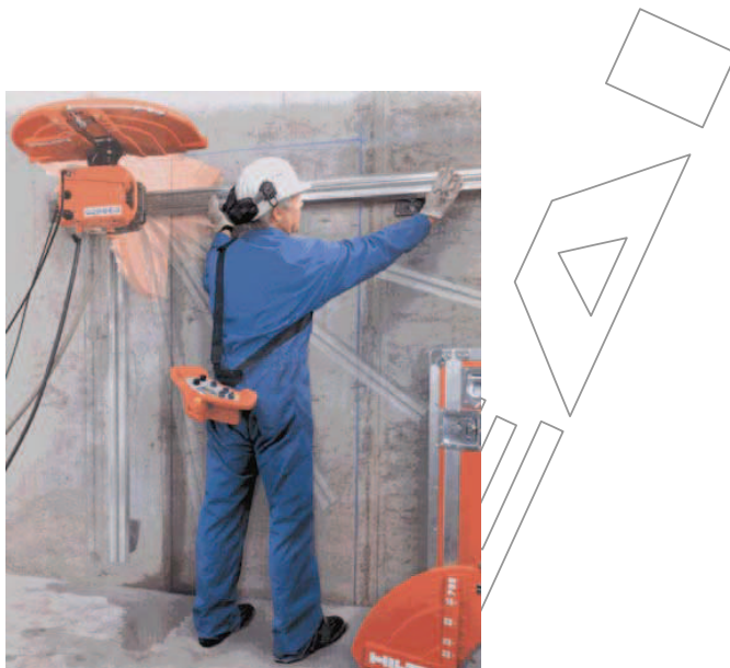
Σχήμα 1 – Κοπή με δίσκο
