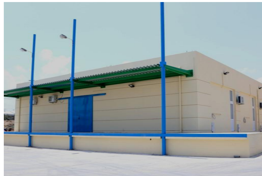
Κατασκευή & Μεταφορά της Ιχθυαγοράς
