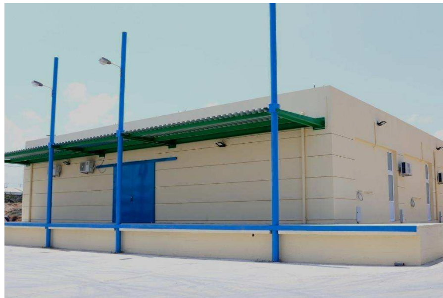
Κατασκευή & Μεταφορά της Ιχθυαγοράς
