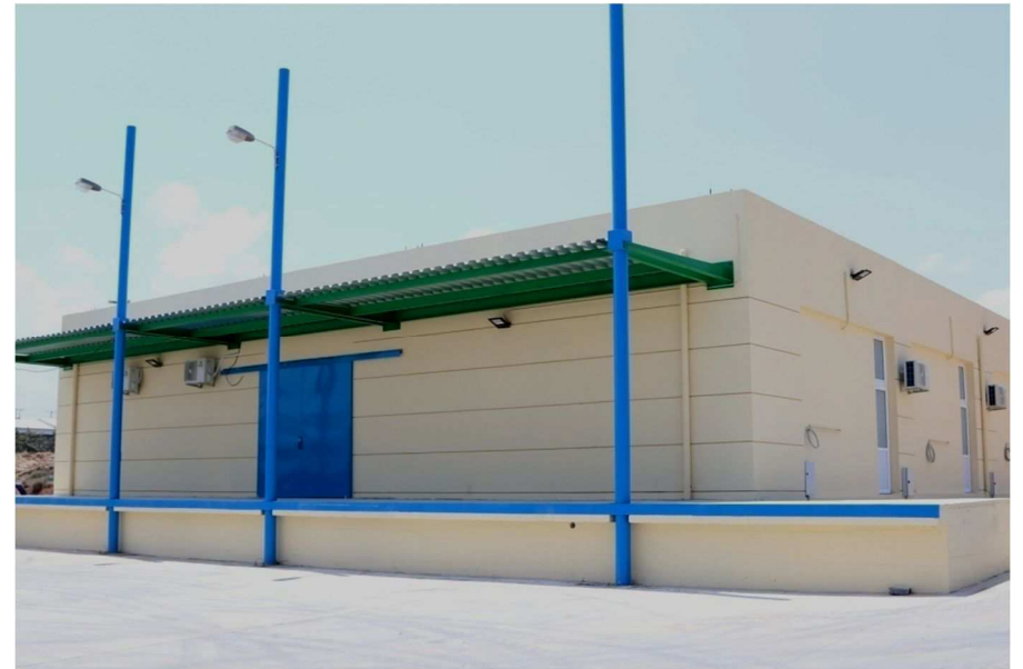
Κατασκευή & Μεταφορά της Ιχθυαγοράς
