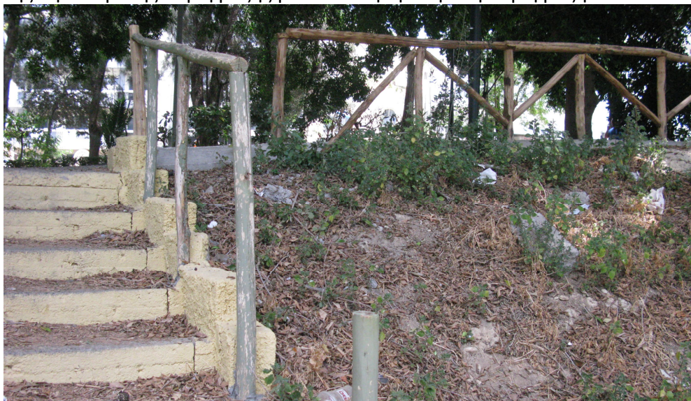
Εικόνα 92: Η περίφραξη στο πρανές και στο κλιμακοστάσιο
