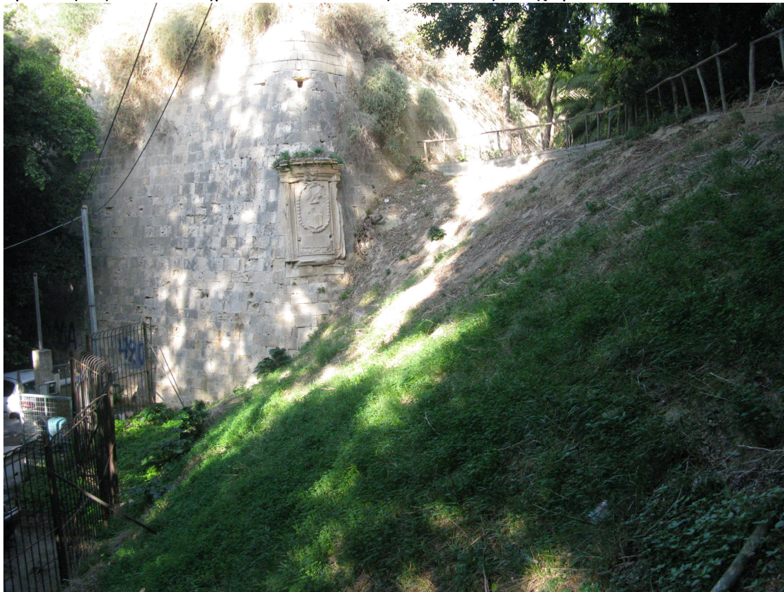
Εικόνα 70: Άποψη του πρανούς 2
