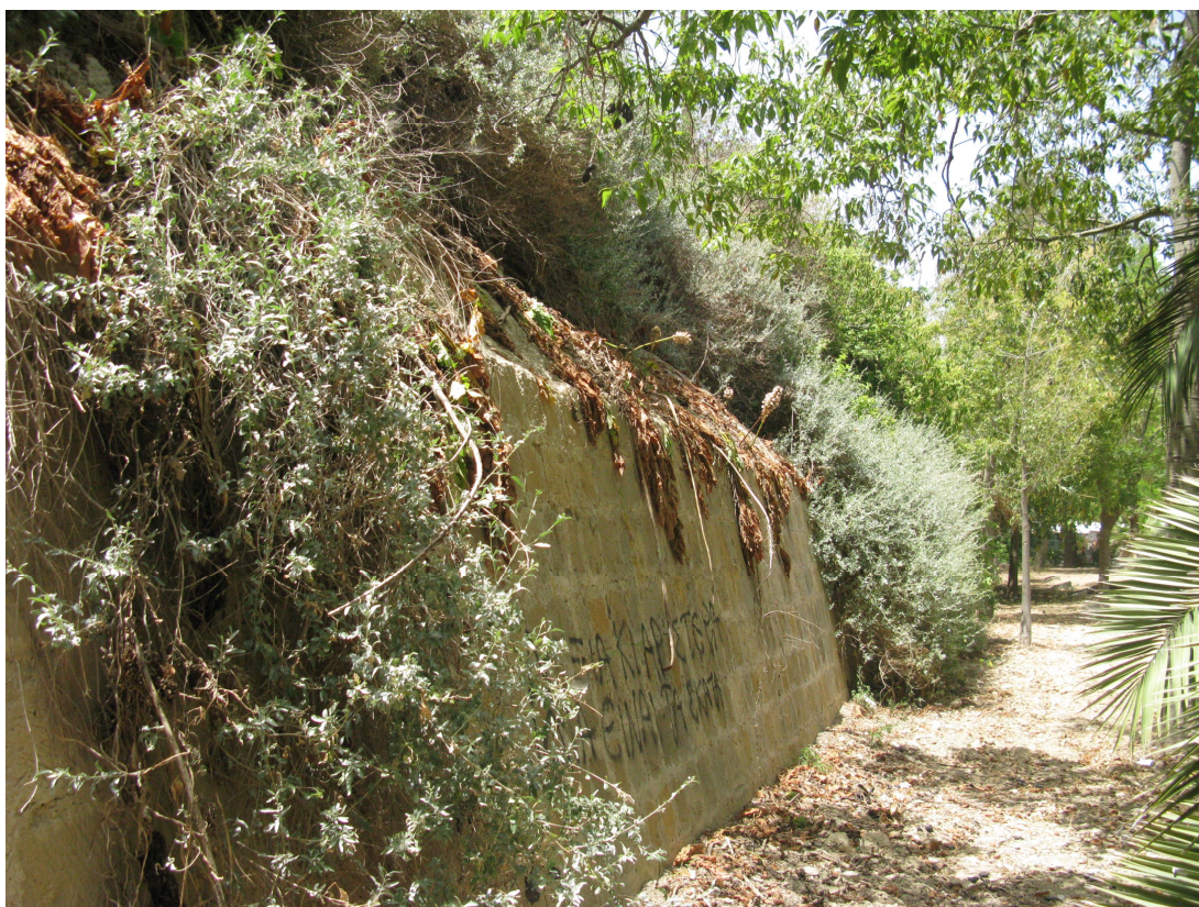
Εικόνα 77: Τμήμα του ενετικού τοίχους δυτικά του πάρκου (στο Π17)
