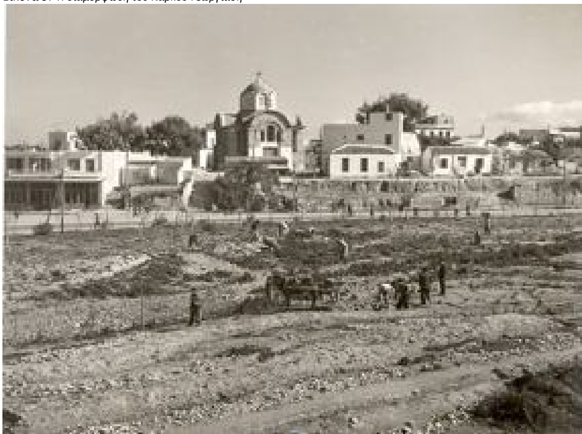
Εικόνα 10: Εργασίες διαμόρφωσης Πάρκου Γεωργιάδη
