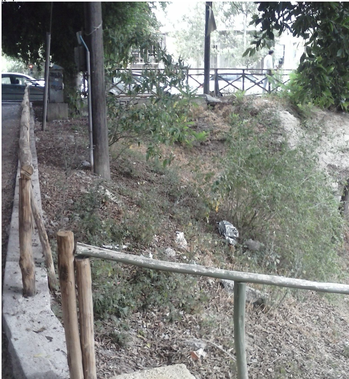
Εικόνα 69: Άποψη του πρανούς 1
