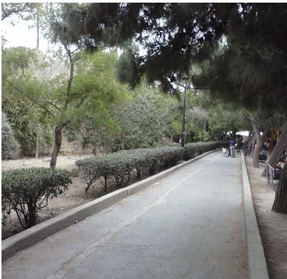
Εικόνα 90: Ασφαλτοστρωμένος διάδρομος πάρκου
