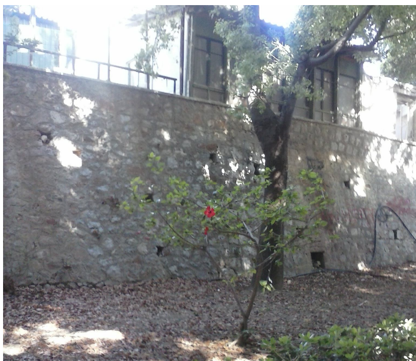
Εικόνα 78: Τμήμα του ενετικού τοίχους δυτικά του πάρκου (στο Π11)
