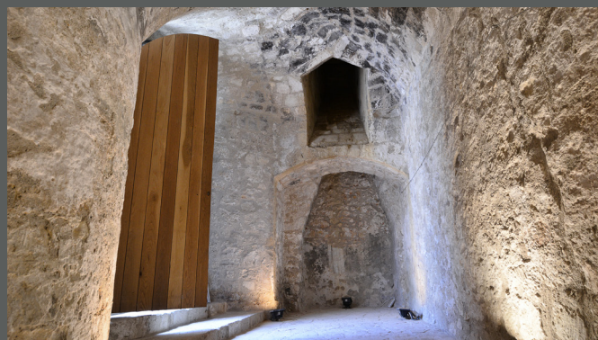
Εσωτερική άποψη της στοάς εξόδου.
