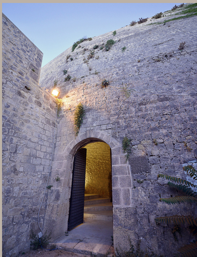
Η εξωτερική πρόσοψη της στοάς εξόδου στην τάφρο.
