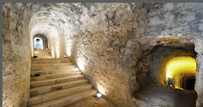
Στοά εξόδου, άποψη από την τάφρο προς την χαμηλή πλατεία της Πύλης Βιττούρι. Δεξιά η «μίνια», τμήμα υπόγειου δικτύου σηράγγων για την ανθυπονόμευση του εχθρού.
