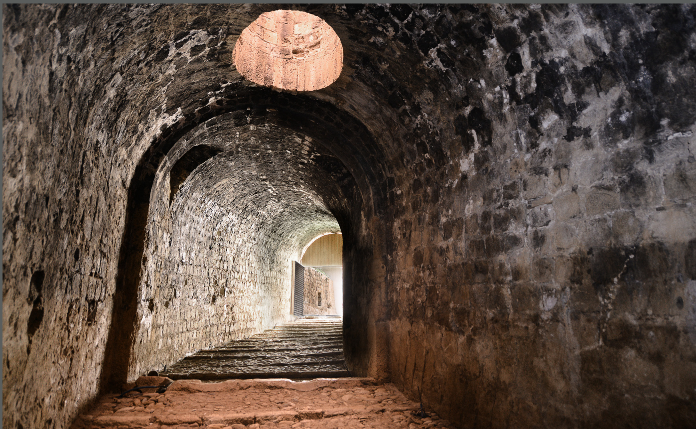
Άποψη του εσωτερικού της θολοσκεπούς στοάς, η οποία οδηγεί από την την έξοδο, σημερινό ΚΤΕΛ, προς εσωτερικό της πόλης
