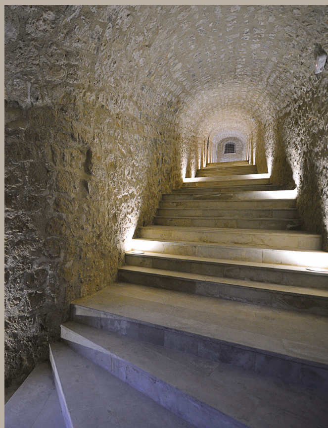
Το εσωτερικό της στοάς εξόδου "sortita" προς την τάφρο.
