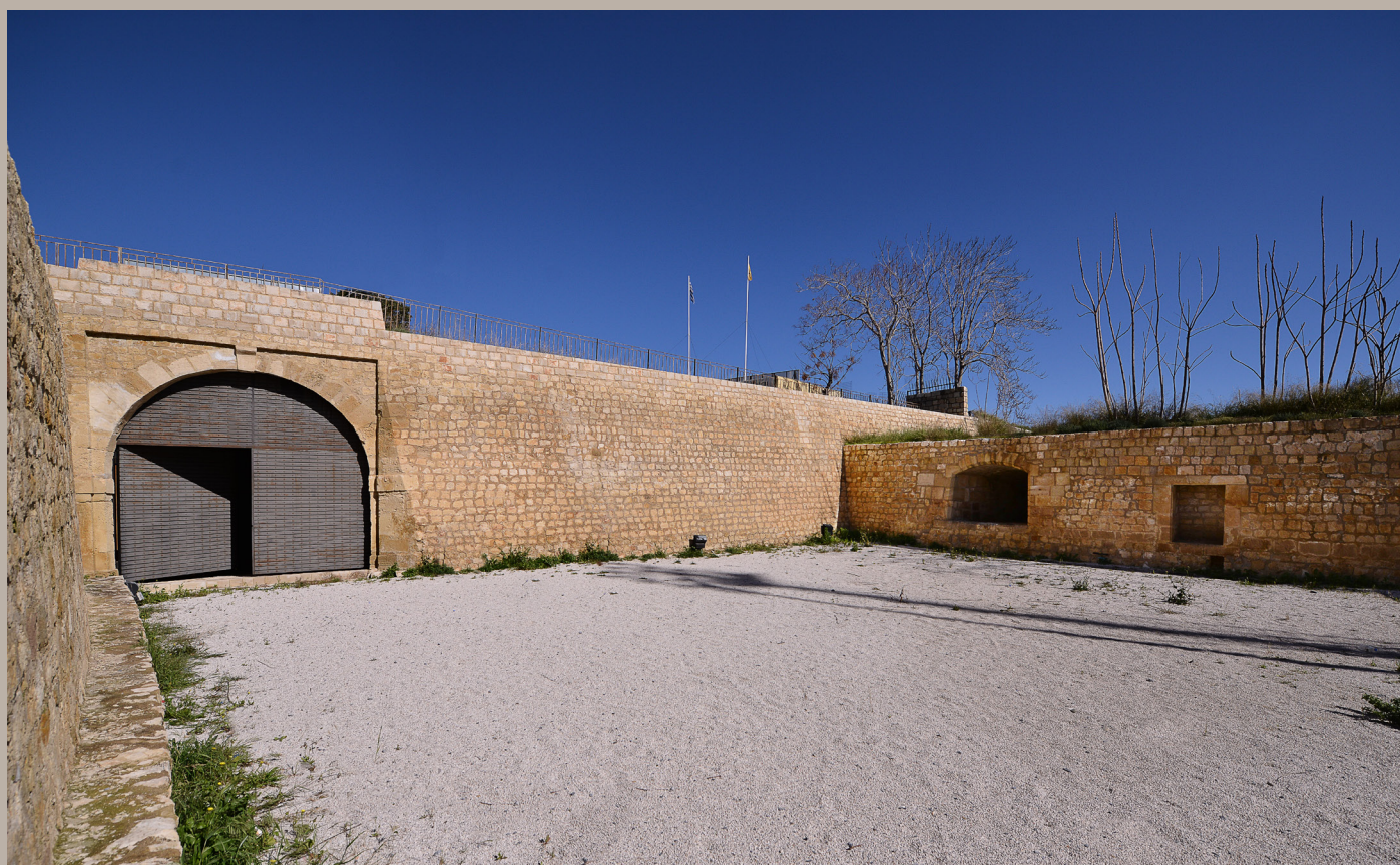
Άποψη της χαμηλής πλατείας στην οποία οδηγεί η στρατιωτική πύλη Μακάσι.
