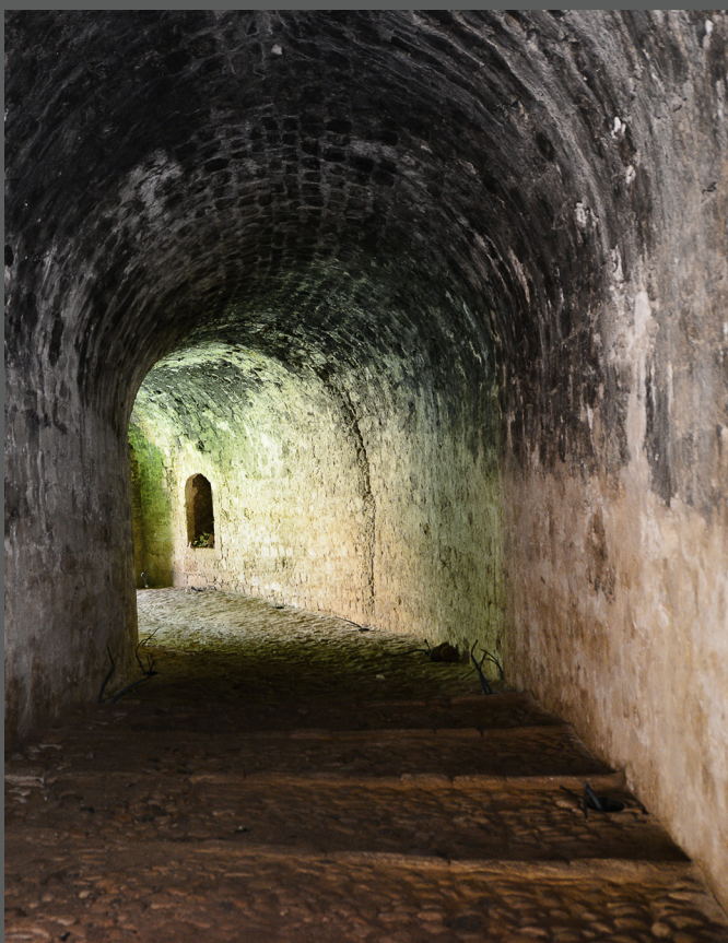
Άποψη από νότο του εσωτερικού της θολοσκεπούς στοάς, η οποία οδηγεί από το εσωτερικό της πόλης προς την έξοδο, σημερινό ΚΤΕΛ
