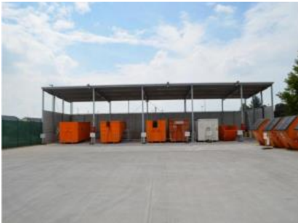
Εικόνα 21: Εξωτερικός χώρος πράσινου σημείου
