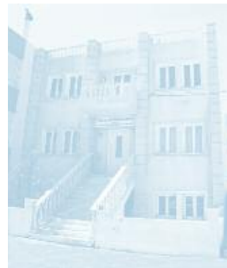
ΚΕΝΤΡΟ ΔΗΜΙΟΥΡΓΙΚΗΣ ΑΠΑΣΧΟΛΗΣΗΣ ΚΑΙ ΕΚΦΡΑΣΗΣ ΠΟΛΙΤΙΣΤΙΚΟΥ ΣΥΛΛΟΓΟΥ ΑΓΙΑΣ ΑΙΚΑΤΕΡΙΝΗΣ (ΝΕΟ ΙΔΙΟΚΤΗΤΟ ΚΤΙΡΙΟ)
