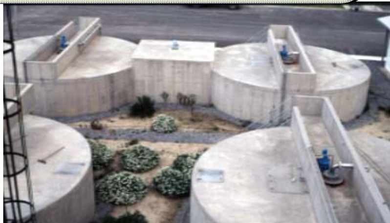
Βιολογικός Καθαρισμός Δεξαμενές Παχύνσεως λάσπης
