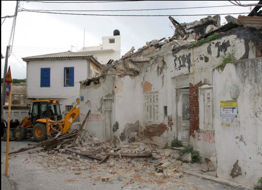
Διάνοιξη οδού Βαλέστρας
