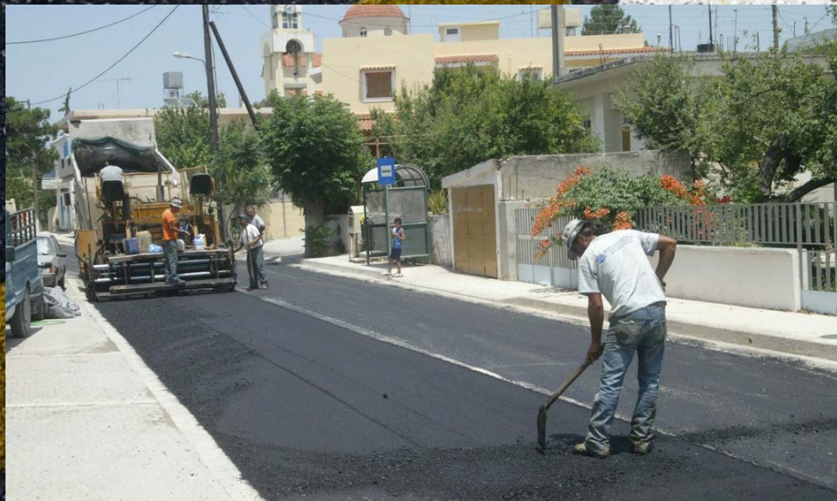
Ασφαλτοστρώσεις σε Αγροτικούς δρόμους
