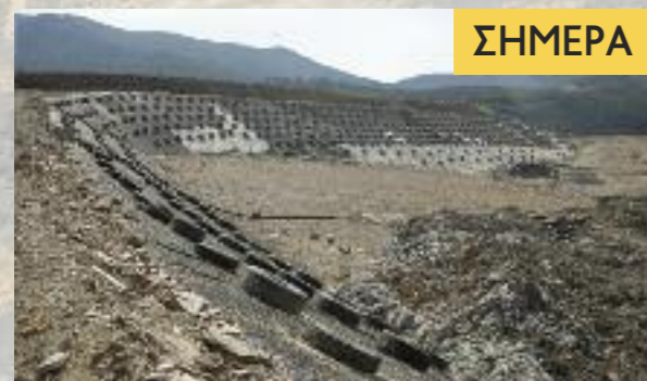
Νέο Κύτταρο ΧΥΤΑ με μεμβράνες για αποφυγή απορρόφησης στραγκίσματος
