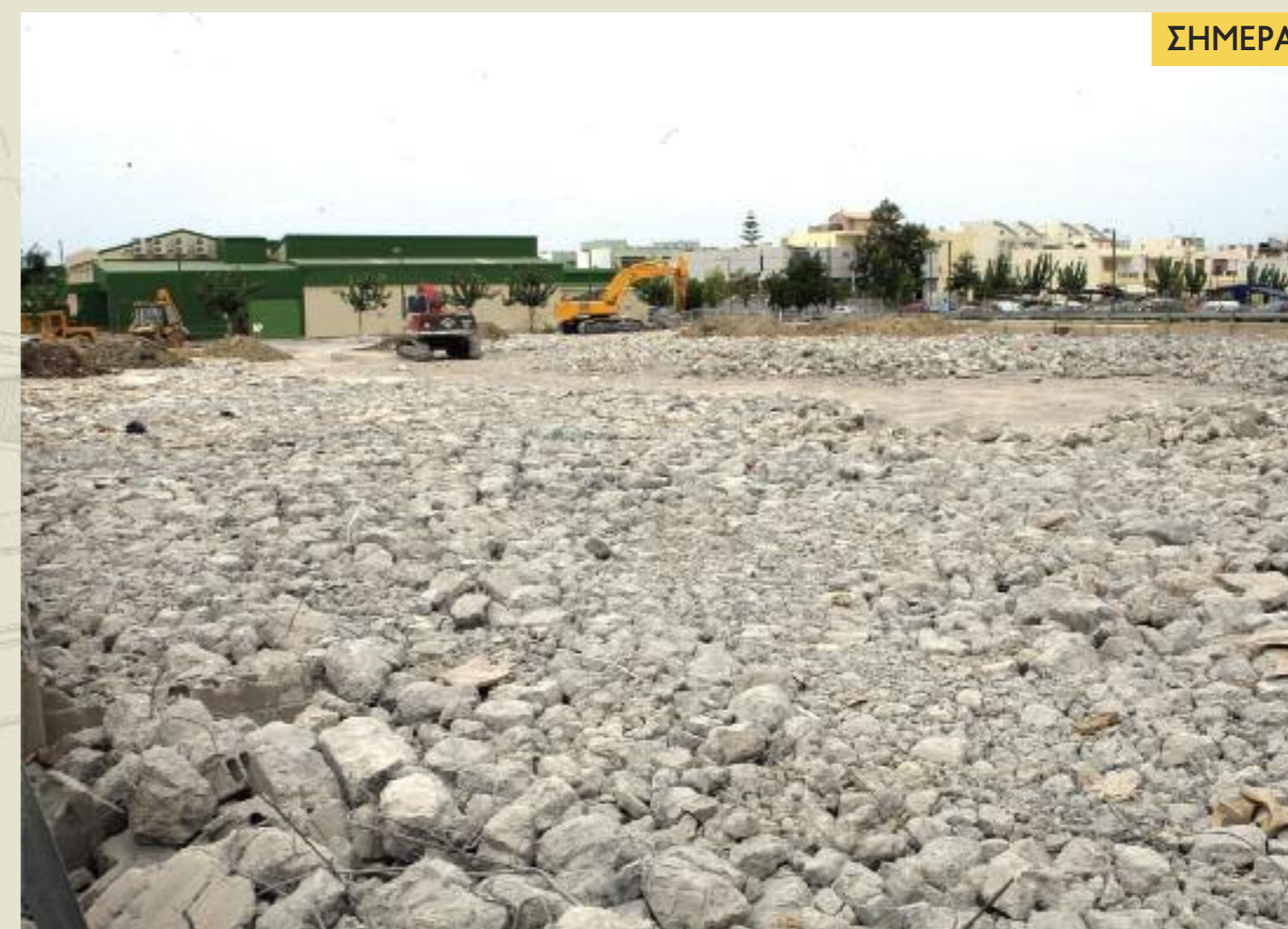
Κατεδάφιση κτιρίου πολυκαταστήματος (4.679 τ.μ.) που αποδίδεται στους πολίτες ως χώρος αθλητισμού, πρασίνου, αναψυχής και περιπάτου.
