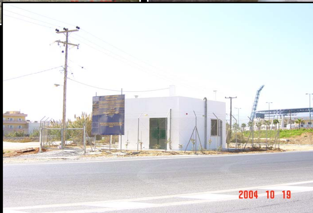
Δίκτυα αποχέτευσης Καρινίων και κατασκευή Αντλιοστασίου
